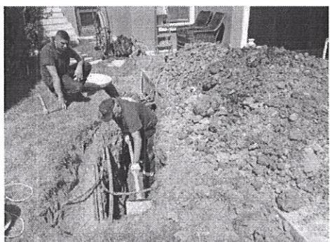
Kooperatifimiz içerisinde bulunan ve bahçe içerisinde kalan yağmur suyu hatları kontrolleri aşamasında Akkavak Caddesi üzerinde bulunan B142 ile B146 arka bahçe içerisinde kalan yağmur suyu hatları arızası B142b nolu villada suyun geri basmasıyla ortaya çıkmıştır. Arıza tespiti aşamasında eski hattın çöktüğü belirlenerek güzergahta kazı çalışması ile yenileme yapılarak hat çalışır vaziyete getirilmiştir.
