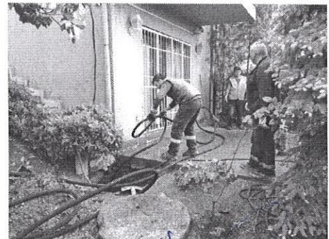
Senelik planlanan yağmur suyu hattı kontrolleri kritik bölgeler başta olmak üzere bakım ve temizliğine devam edilmiştir. Cadde ve sokaklardaki yağmur suları için yapılan mazgalların temizliği tıkanıklıkların engellenmesi adına çalışma yapılmıştır.
